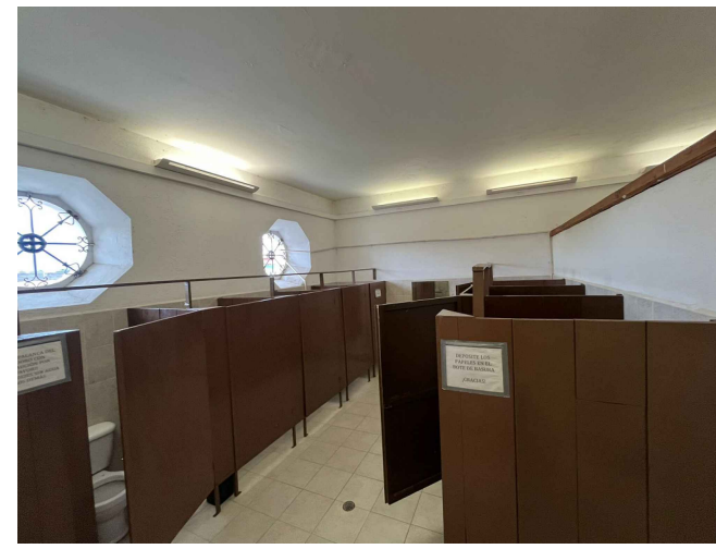
F08. Desplome de puertas de madera causados por falta de mantenimiento.
