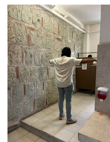
F08. Sanitario mujeres en planta alta, del lado izquierdo se observa muro aparente mixto de piedra cantera y ladrillo de barro rojo recocido.
