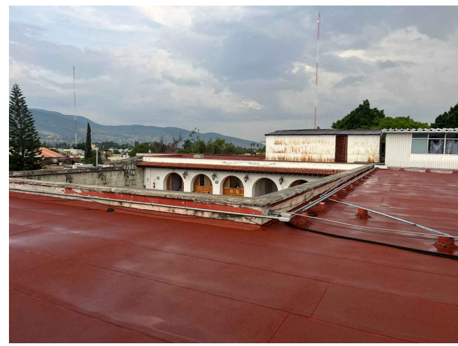
F07. Losa de azotea, se observa preli con tapa de ladrillo y ductería galvanizada.
